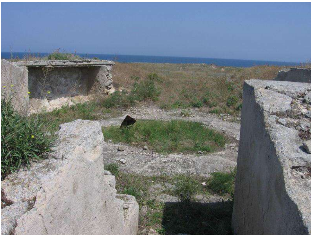
Орудийный дворик 152 мм орудия системы Кане с нишами под боезапас
