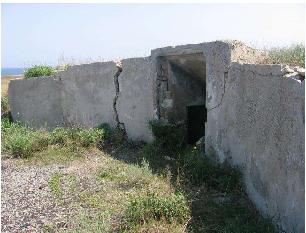
Орудийный дворик 152 мм орудия системы Кане с нишами под боезапас
